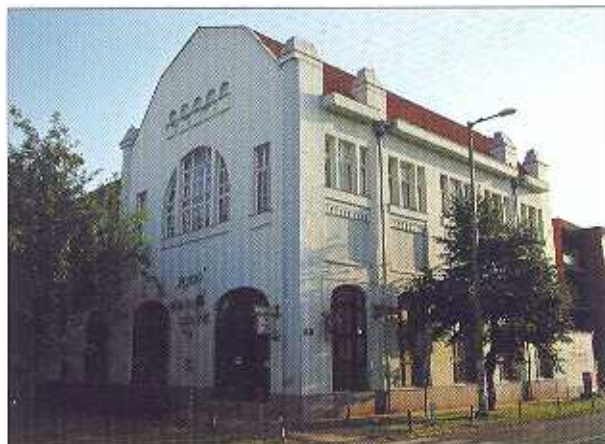
Az 1909-ben épült és 2001-ben felújított Vigadó
